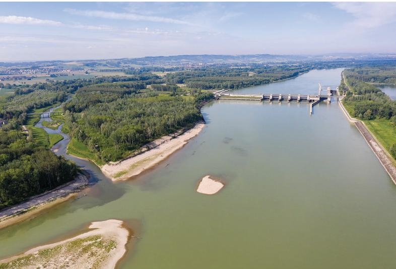
**Bild 5:** Mündung der Fischwanderhilfe Ottensheim-Wilhering: Flussauf der Mündung wurde das steile, mit Steinen gesicherte Ufer abgeflacht, flussab der Mündung befindet sich der bereits vorab hergestellte Nebenarm Marktau, im Hintergrund befindet sich das Kraftwerk Ottensheim-Wilhering zu sehen
