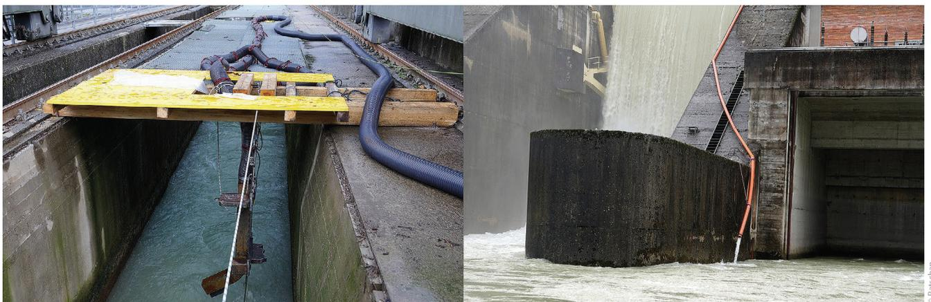
**Bild 1:** Schlauch und absenkbares Injektionssystem (links) und Rohr zur Beigabe der Kontrollgruppe (rechts) beim Draukraftwerk
