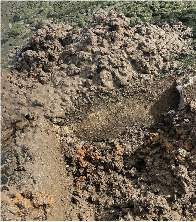
**Bild 2:** Stark verockerter mineralischer Filter, das Deckwerk wurde zur Probenahme entfernt und war vorher nicht beschädigt
